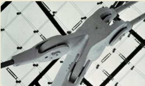
Knoten einer Hängedachkonstruktion im Münchener Olympiastadion
