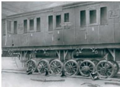
图2b: 1903年DWF现场测试。轴箱装有两个深沟球轴承(资料来源: 1909年5月型录)。
