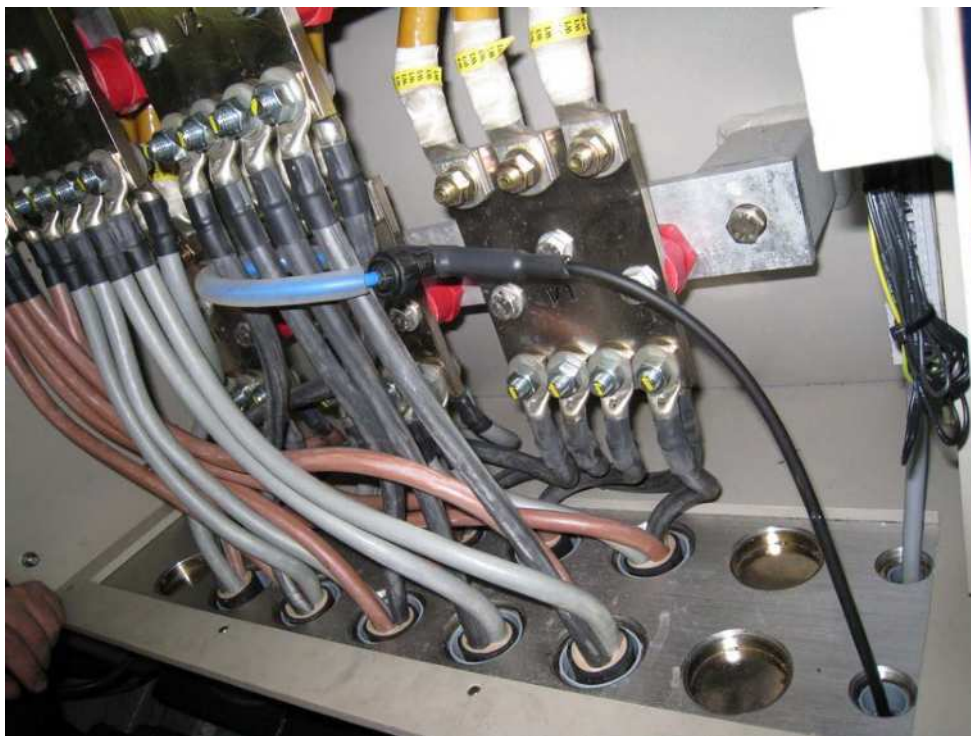
图 3 - 7. 测量灵活负载传感器其中一根发电机相位电缆。
