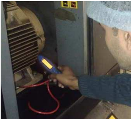
1 Zur Überwachung von Schwingungen den SKF Machine Condition Advisor CMAS 100-SL
