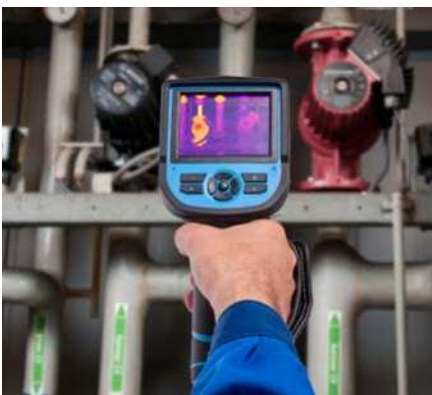
3 Zum Erstellen von Wärmebildern die SKF Wärmebildkamera der Baureihe TKTI
