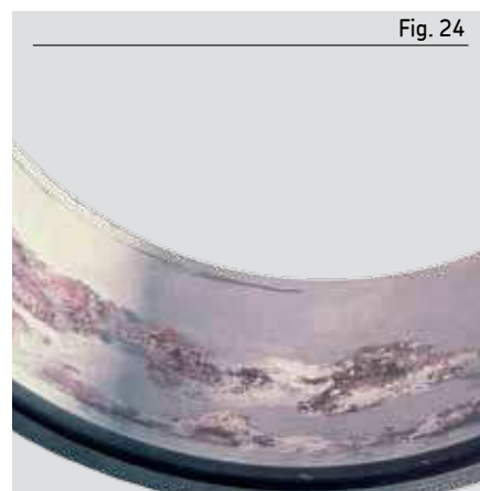
Corrosión por contacto en el agujero de un aro interior causada por un asiento de eje inadecuado o flexión del eje
