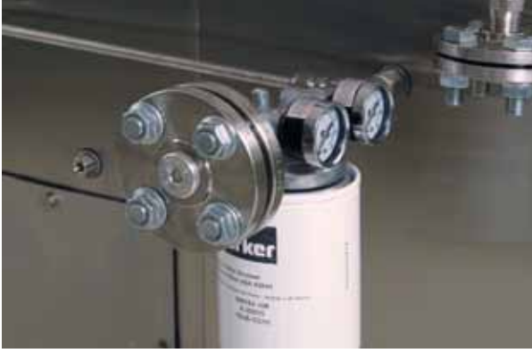
Şek. 17 Otomatik Yağ Takviye Bağlantı Flanşı (Mahfaza Dışı)
