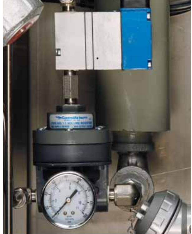
Şek. 11 I/P Ölçerli Dönüştürücü - Yükseltici
