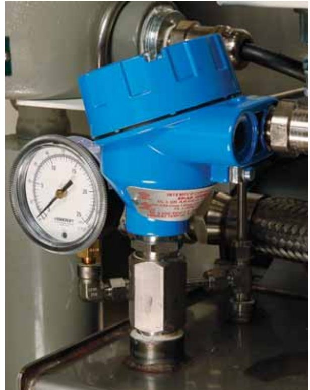
Şek. 12 Buhar Basınç Ölçer ve Yağ Düzeyi Sensörü
