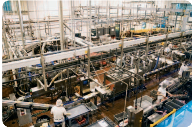
Einsatz von Ketten aus nichtrostenden Stahl in einer Käserei
