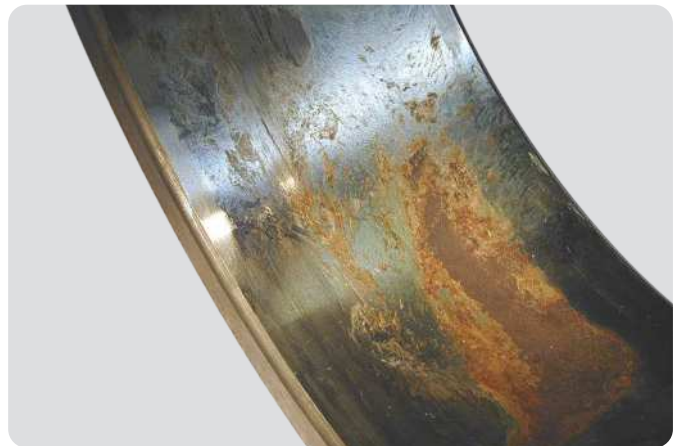
Bague intérieure de roulement à rouleaux cylindriques Ajustement sur l'arbre inapproprié, support irrégulier
