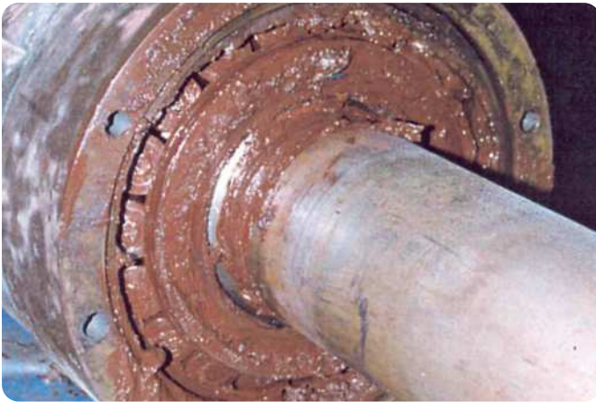
Roulement à rouleaux coniques dans une pompe Défaillance de l'étanchéité, corrosion du roulement et coloration rougeâtre de la graisse
